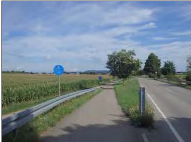
Radweg Biengener Allee, unbeleuchtet
