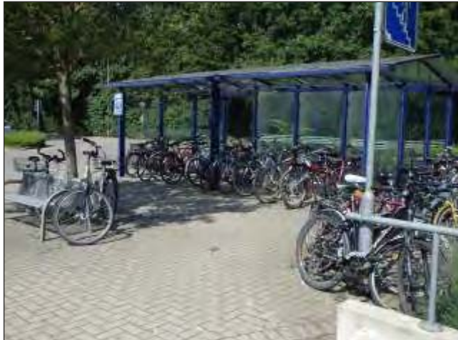
Radabstellanlagen am Bahnhof (Westseite)
