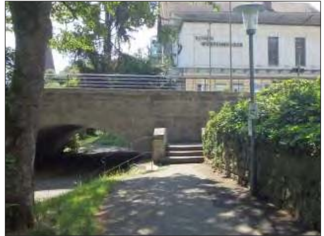
Fußweg am Neumagen, Querung Basler Straße
