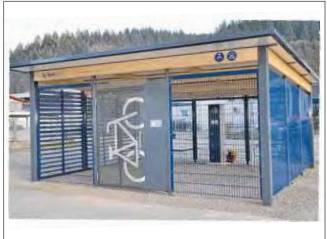
Prototyp einer Park & Bike-Anlage in Bad Oldesloe (Quelle: NAH.SH)
