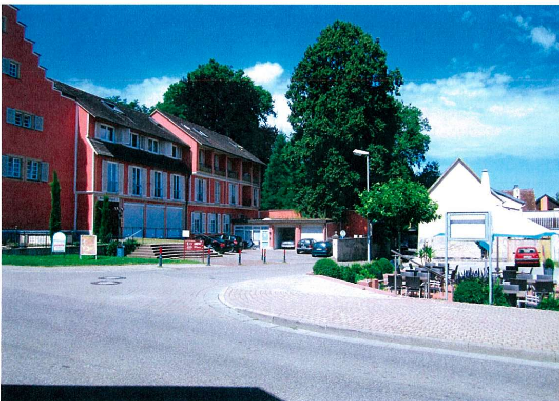
Bereich des zukünftigen Schlossplatzes
