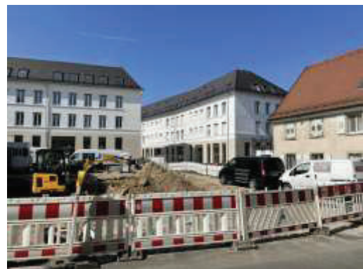
Blick von Norden auf den Bereich des neuen Rathausanbaus
