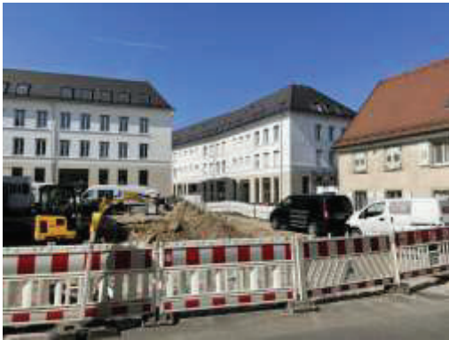
Blick von Nordosten, im Vordergrund die Baustelle für den Rathausanbau
