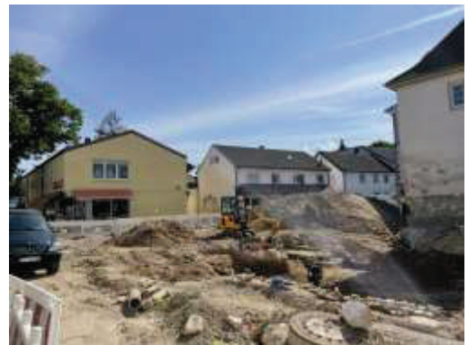
Blick von Südwesten, im Vordergrund die Baustelle für den Rathausanbau
