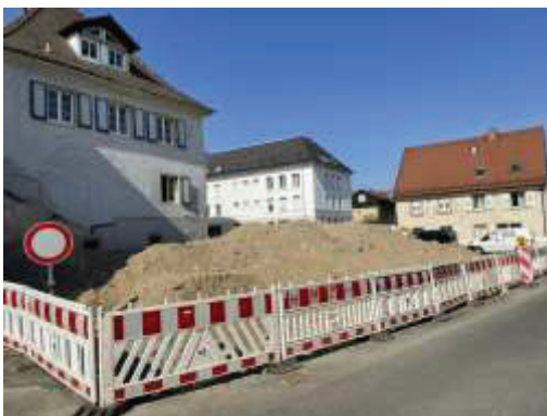
Blick von Nordosten auf das Rathaus (links) und den Bereich für den neuen Rathausanbau
