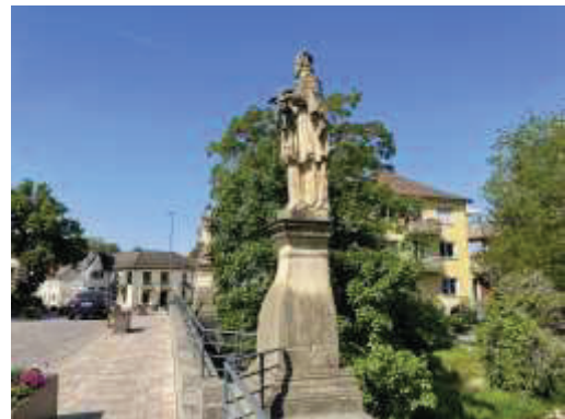
Blick von Norden auf die Brücke
