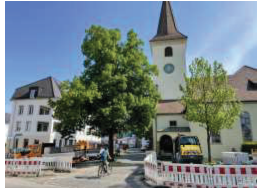
Blick von Süden auf die Kirche und die Neubebauung (links)
