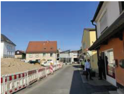
Blick von Osten, rechts die Baustelle für den Rathausanbau
