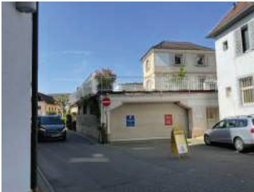
Blick von Norden auf den Rückbereich östlich der Basler Straße
